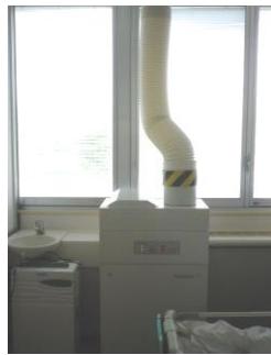
医療用空気清浄装置（簡易陰圧装置）を設置した病室内の様子
